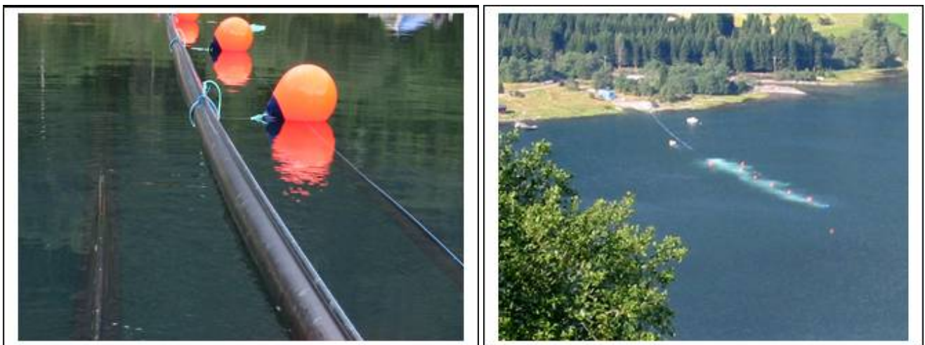
Figur 4.3. 100 m langt boblegardin bestående av 3 diffusorrør (til venstre) senket på 40 meters dyp i Arnafjorden (til høyre).
