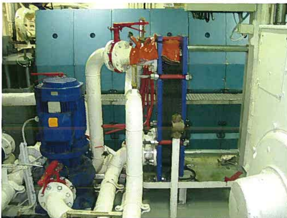
Figur 9 HT / LT varmeveksler her kan HT varme fra kjølevann hentes
