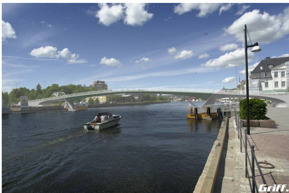
Figur 3.13. 60 m gangbro over Glomma i Fredrikstad. Broen er en mekanisk klaffebro og de to heveklaffene, hver på 30 m, er laget i kompositt- og sandwichmaterialer.
