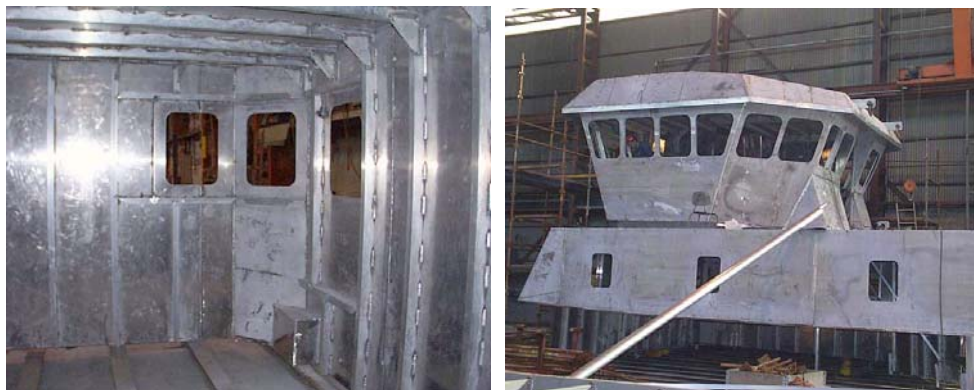
Figur 7: Eksempler på bruk av spanter for å stive av og forsterke platefelter i et aluminiumsoverbygg. Bildene er hentet fra Naval-Consult sine hjemmesider.
