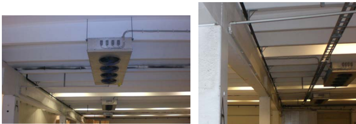
Figur 2 Fordamper-rekker i kjølelager
