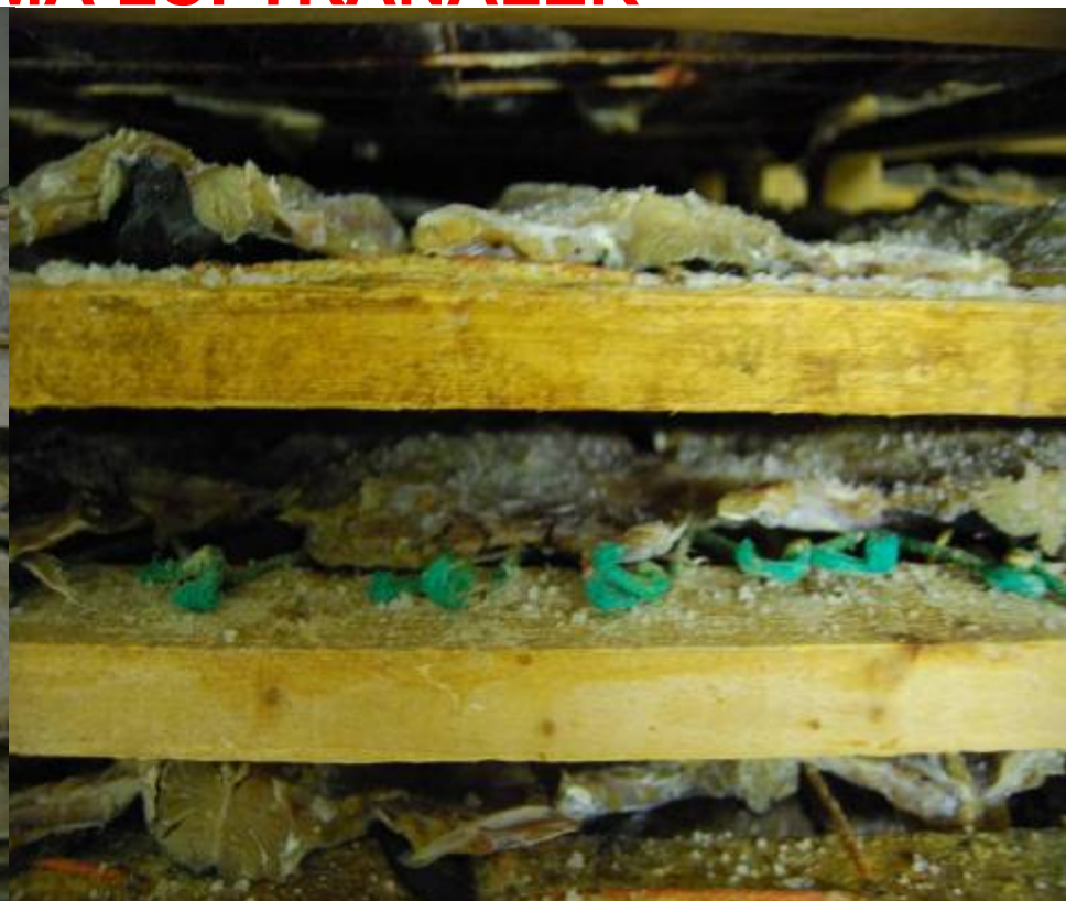
LUFTKANALER PÅ VOGN
