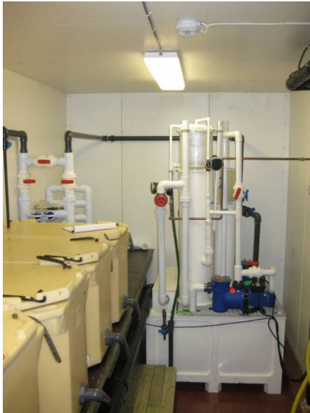
Bilde 11 Viser mottaksstasjon for levende kreps og kongekrabbe "krabbehotell" i Tromsø basert på 100 % resirkulering (RAS).
