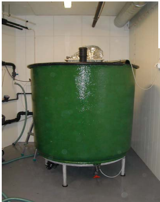
Produksjonstank (1,8m 3 ) med røktearm og utvendig lufting
