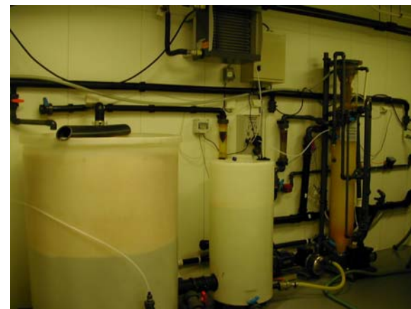
Biofilter, pumpeump og proteinskimmer
