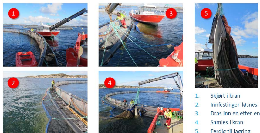
Figur 8: Dokumentasjon av skjørtopptak ved fargestoffforsøk på Helligholmen, operasjon tok ca. 1 time.
