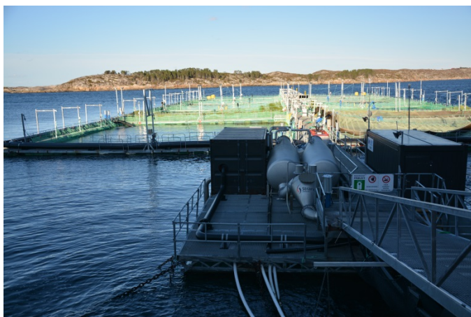
Figur 1 - Laks til prosessering og forsøk ble tatt ut fra Ventemerdd 2 som er andre ventemerdd i rekken på venstre side i bildet. Bildet viser også plasseringen av de doble trykk/vakuumpumpene som forsyner slakteriet med fisk. I brakken til høyre for pumpen styres og overvåkes trengeprosessen.
