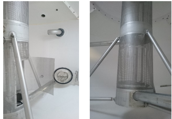
Bilder av en tank innvendig.
