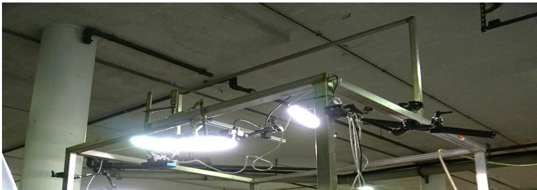
Figur 16 - Rammen for oppheng av lysrigg og kamera under testing.
