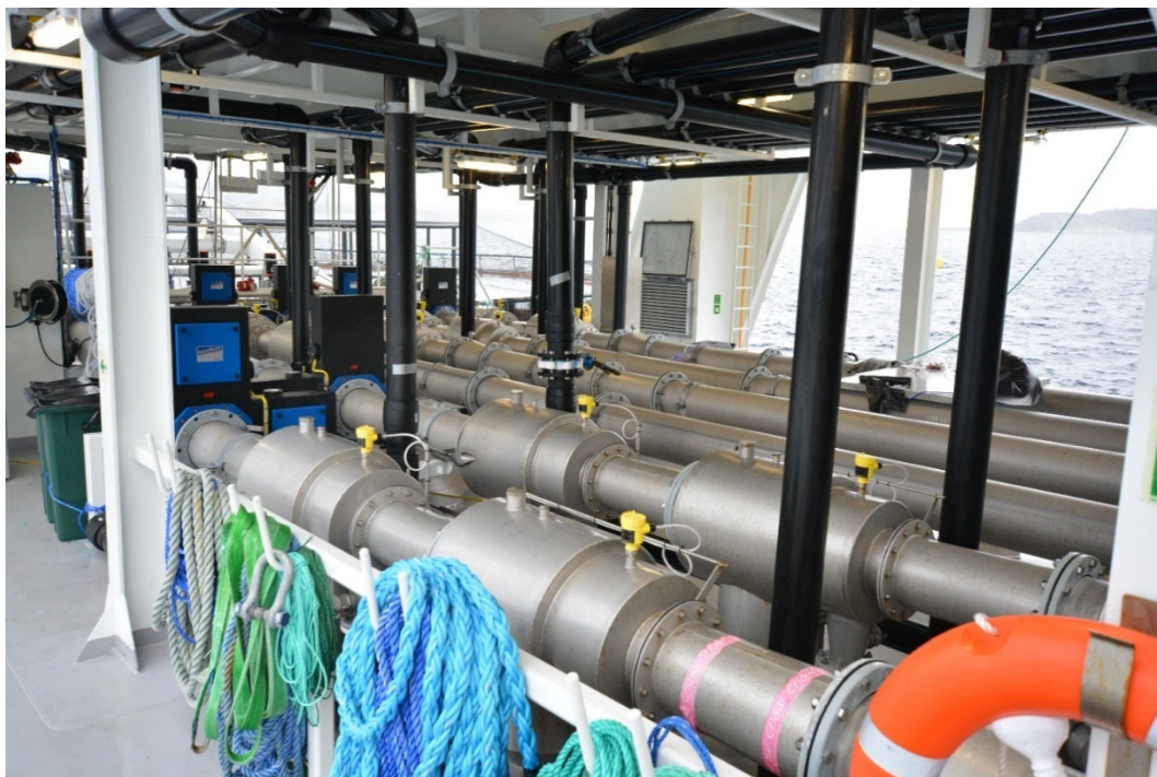
Figur 8 - Bildet viser to seriekoblede enheter (nærmeste rørgate) for avlusing på hydrolicerens dekk. Som vist har Hydrolicer LG9332 Hydro seks parallelle rørgater.
